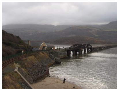
Pont reilffordd trestl dros Aber y Fawddach. Delwedd © Fiona Fyfe
