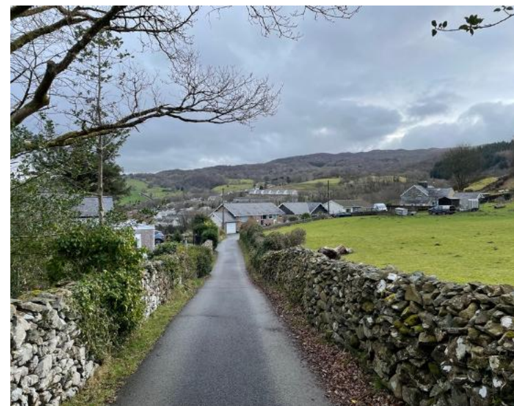
50 Wal garreg, Ffordd Bodlondeb. (2022).
